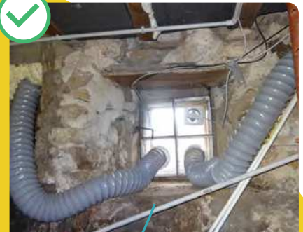
Extracteur mécanique et prise d'air de la cheminée vers l'extérieur
