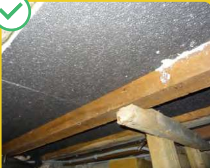
Isolation du plafond de la cave
