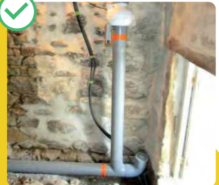
captation Système SDS et évacuation de l'air « vicié » vers l'extérieur
