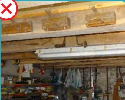
Cave avec poutres au plafond
