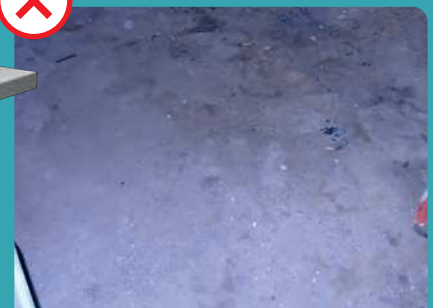
Sol du garage en terre battue
