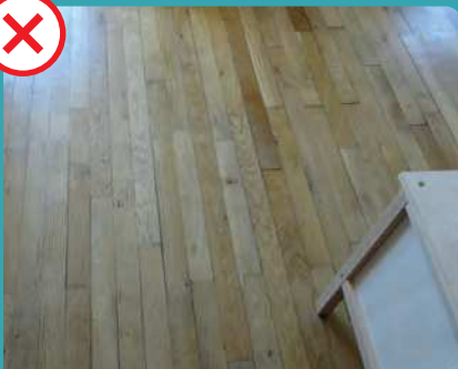
Plancher bois seul, sans chape béton
