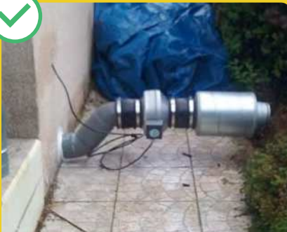
Systeme de dépressurisation des sols (extraction du radon)
