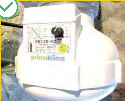
Extracteur de conduit centrifuge à puissance variable
