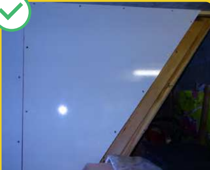
Sas entre le sous-sol et le logement
