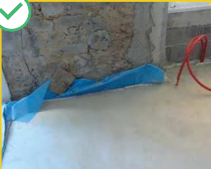
Plancher bas en chape béton avec film pare-radon
